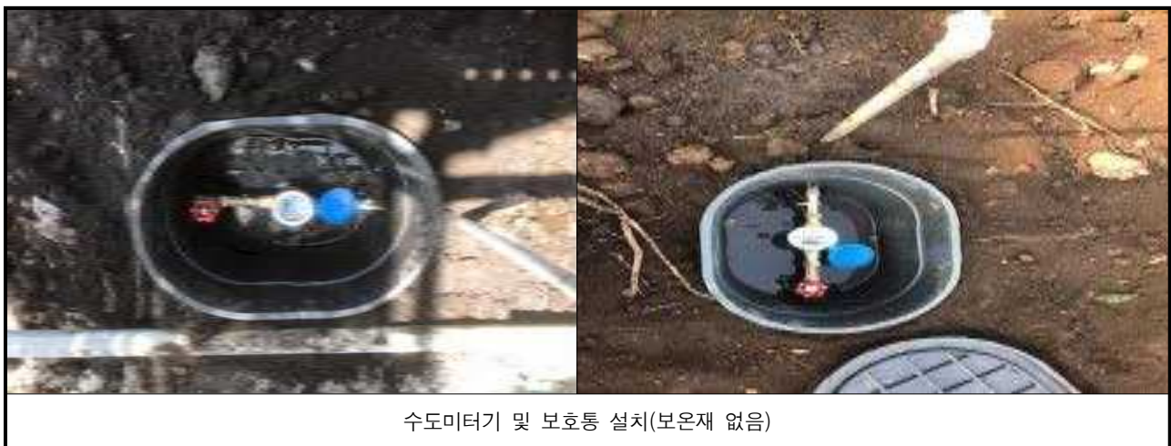
[그림 2] 한림읍 관내 구경 15~50mm 수도미터 및 보호통 설치 사진
